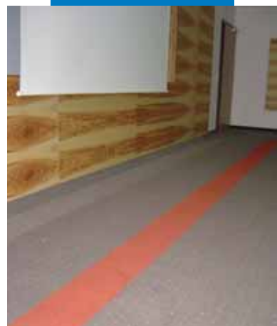
Παράδειγμα εφαρμογής Primer G πριν την εφαρμογή του Ultraplan Eco και της κόλλας Rollcoll , που χρησιμοποιήθηκε για τη συγκόλληση χαλιού σε ένα δωμάτιο ξενοδοχείου - Ξενοδοχείο Villa Castellani - Αυστρία
